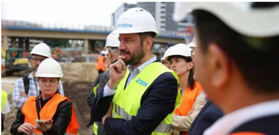
Prezydent Miasta Krakowa Aleksander Miszalski podczas wizyty na placu budowy tramwaju na osiedlu Olsza II przy ul. Młyńskiej w okolicach ronda Polsadu, 12 czerwca 2024 r. Fot. UMK
