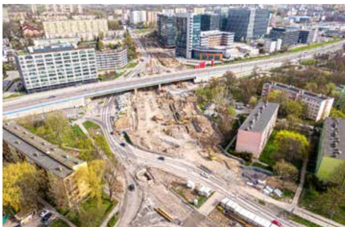
Plac budowy w rejonie ronda Polsadu z lotu ptaka. Fot. Tramwaj do Mistrzejowic
