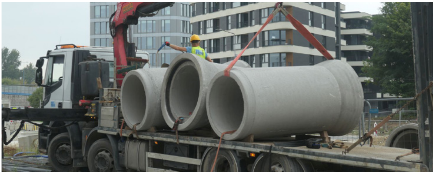
Wyładunek kolejnej partii materiałów na placu budowy przy ul. Lublańskiej. Fot. Mateusz Drożdż
