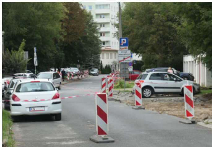
Remont parkingu przy ul. Mariana StONECKIEGO. Fot. Mateusz Drożdż
