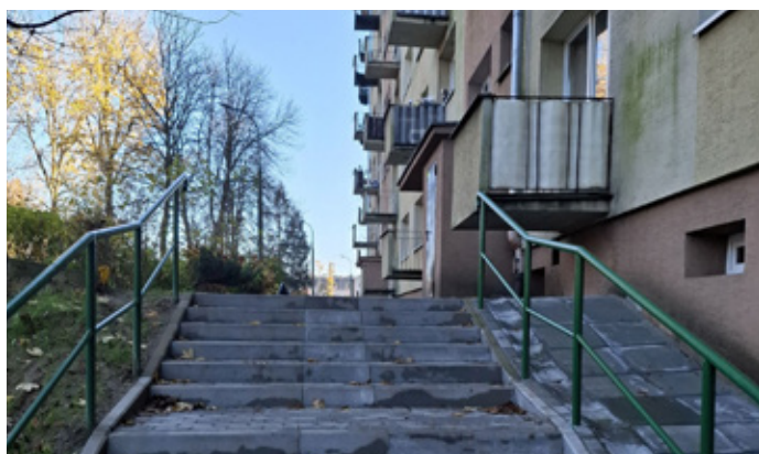
Wyremontowane schody przy ul. Ugorek. Fot. Maciej Kalemba
