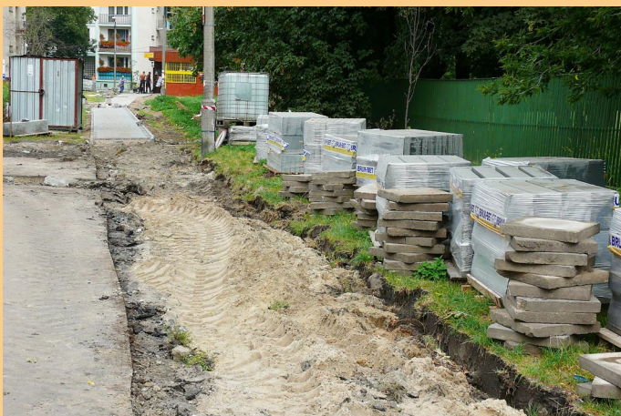
Ul. Nieduża – remont chodników.
