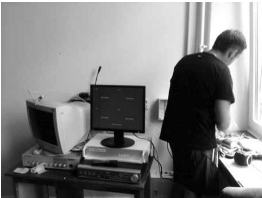
Montaż monitoringu boisk sportowych w Szkole Podstawowej nr 114, z boku obok nowego sprzętu znajduje się starszy zakupiony ze środków Dzielnicy III w latach 2003-2006. Fot. Dominik Jaśkowiec
