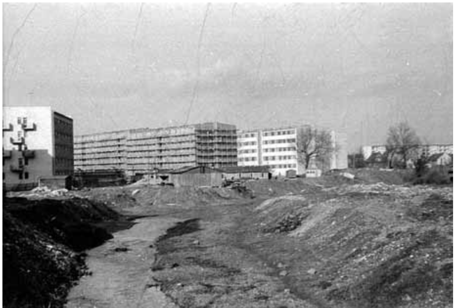
Pół wieku temu tak wyglądał widok z mostu przy ul. Wileńskiej. Plac budowy bloków osiedla Wiśniowa. Fot. Marian Ślósarczyk
