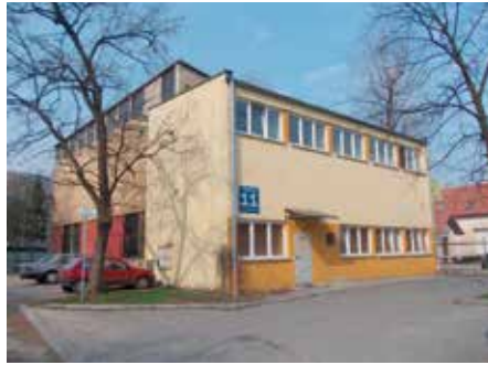
Budynek dawnej osiedlowej kotłowni przy ul. Młyńskiej Bocznej 11. Fot. Mateusz Drożdż
