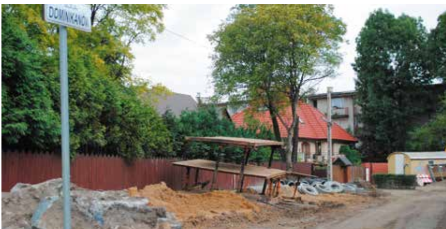
Ul. Dominikanów w trakcie przebudowy. Fot. Mateusz Drożdż
