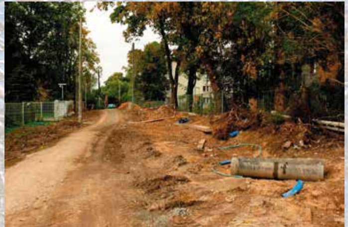
Budowa kanalizacji opadowej i oświetlenia
