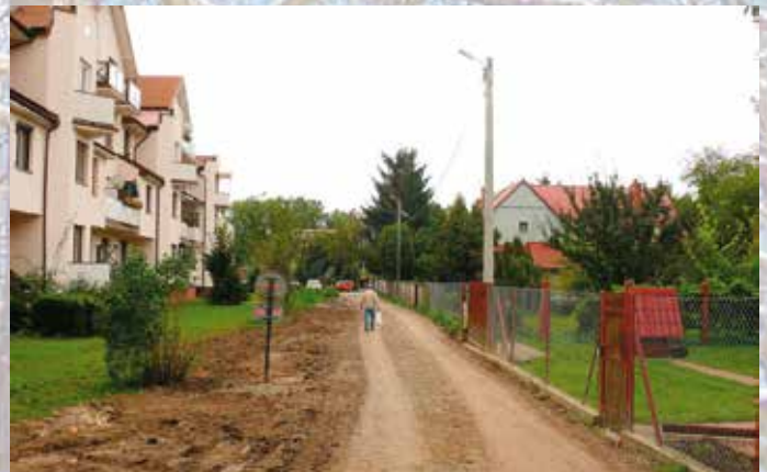
Ulica Rezedowa po przebudowie podziemnej infrastruktury
