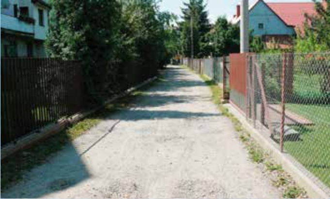
Ulica Rezedowa przed przebudową
