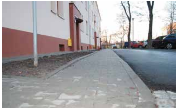
Wyremontowany chodnik przy bloku przy ul. Tadeusza Kantora 4.
