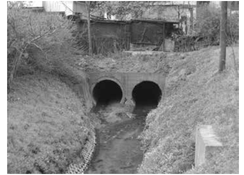
Wylot przepustu wodnego pod ul. Dobrego Pasterza. Fot. Marek Zborowski
